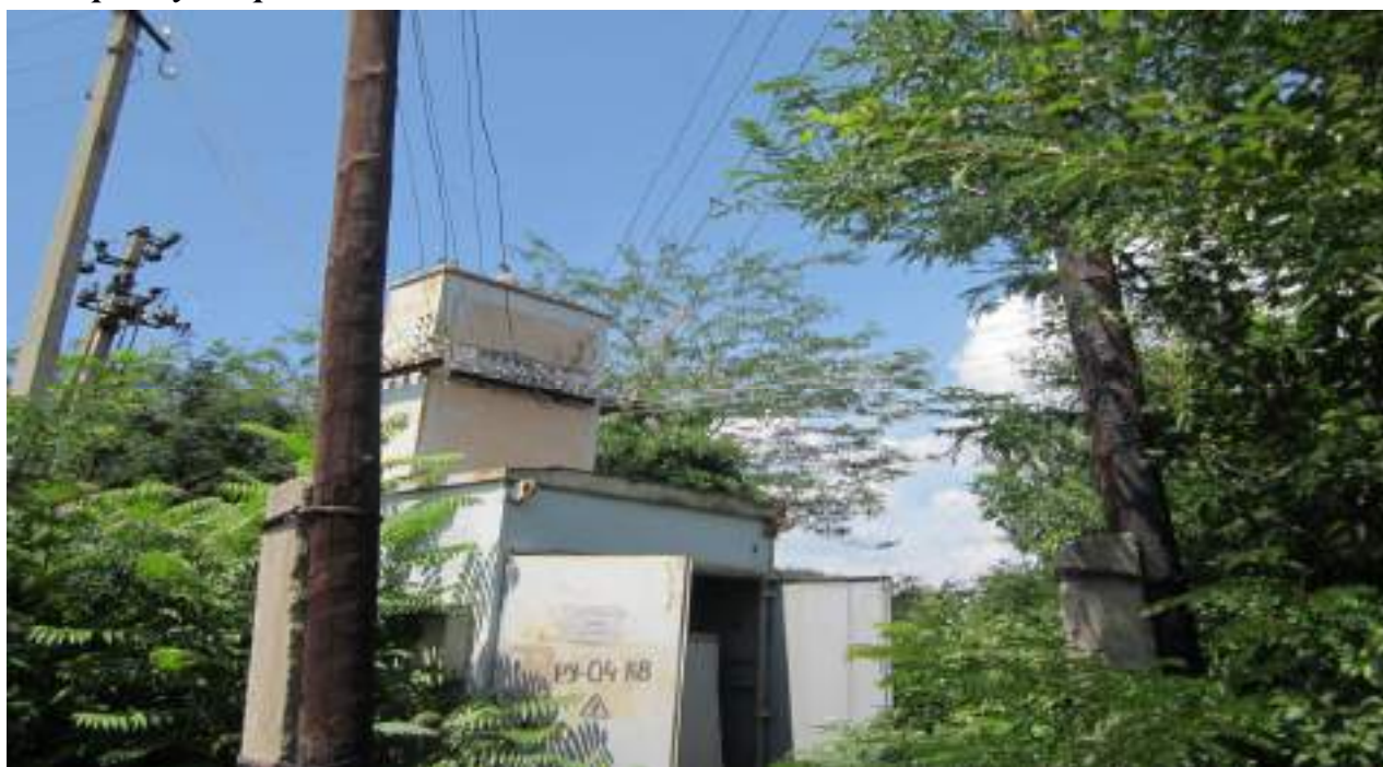
Трансформаторная подстанция – 160 кВт. с.Натырбово. ул.Пушкина и Чапаева. ТП зарос кустарником.
